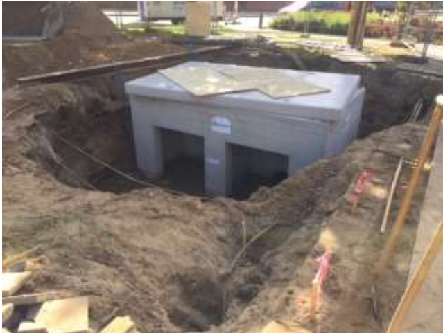
De rioolput die geplaatst is onderaan de Stekkenberg
