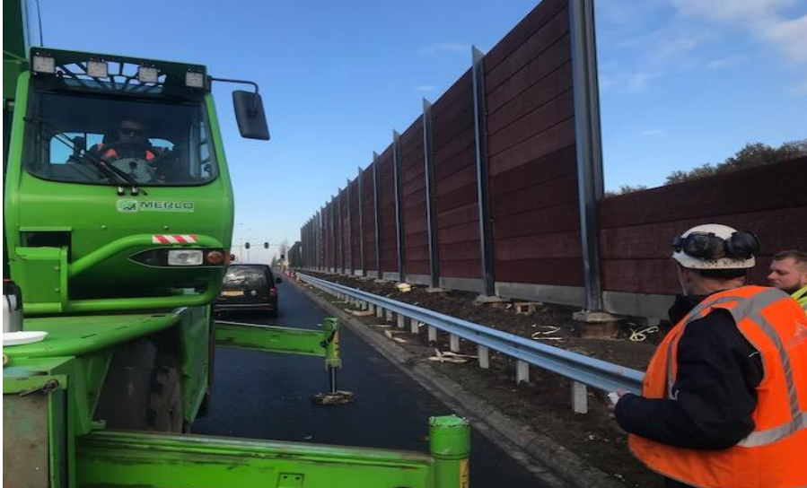
Het geluidsscherm in aanbouw
